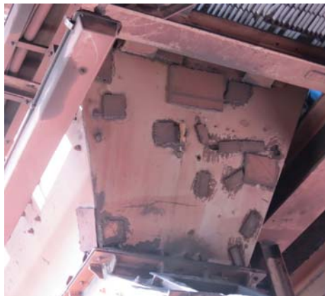
شکل (2) : هر سوراخ ایجاد شده نشانه شکستن یکی از سرامیک ها می باشد
