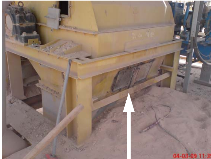
شکل (1) : ورق های ضد سایش نصب شده در دیواره شوت
